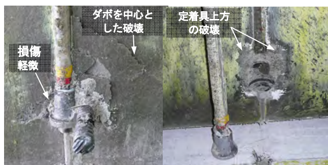
写真5 No.8 試験体 (機械式定着具 B+ダボ筋)
