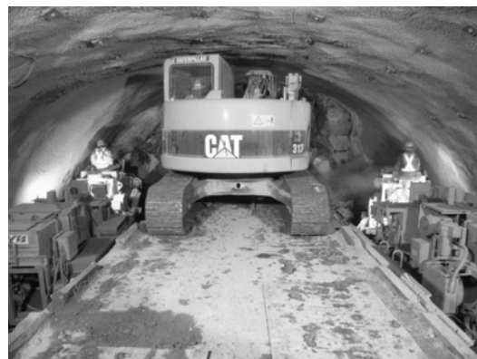
写真3 終点側掘削状況
