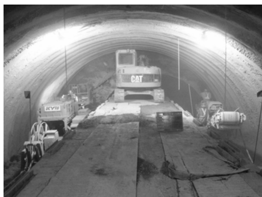
写真2 起点側掘削状況
