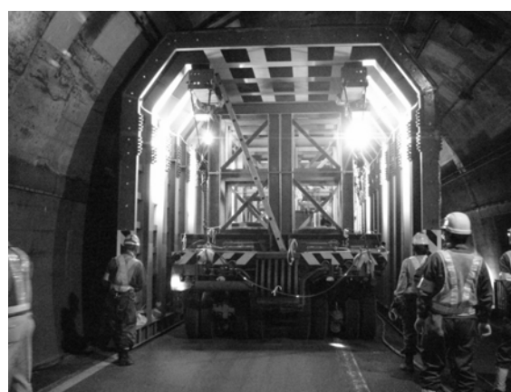
写真1 プロテクター設置状況
