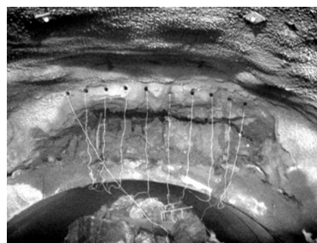
写真4 電撃破砕薬装薬状況
