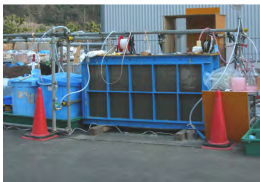
図4 洗浄作業状況
