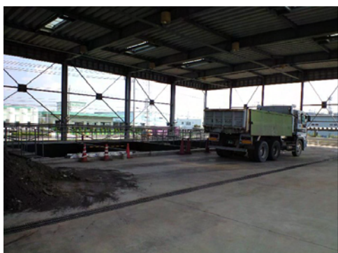
写真2 ダンプトラックによる搬入
