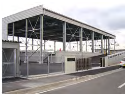
写真1 北九州エコタウンセンター内実証試験施設
