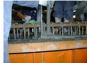
写真 4 Fc60 漏れと打設間隔 90 分での引抜き状況
