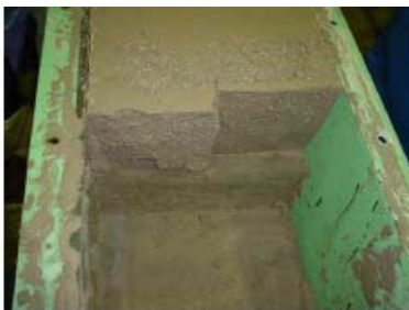
(e)コンクリートブロックの充填状況
