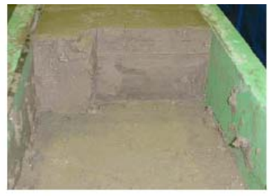
(f)コンクリートブロックの充填状況c)
