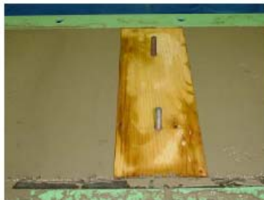
(a)角材周辺の充填状況
