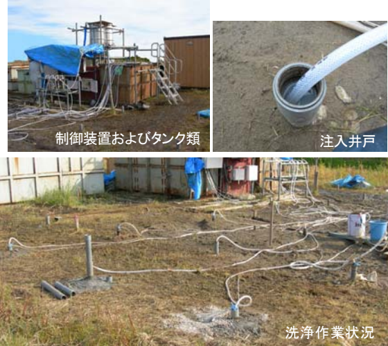
図7 現場施工状況
