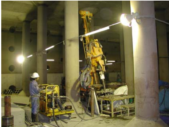
高耐力マイクロパイル施工状況
