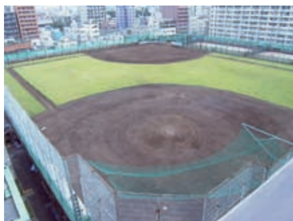
写真 1 亀戸給水所配水池の全景(上部から撮影)
