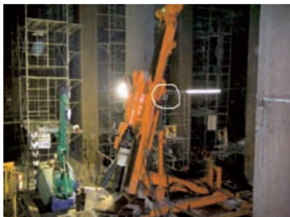
写真 4 角度計の設置状況
