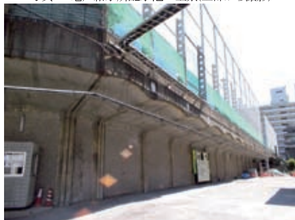
写真 2 亀戸給水所配水池(地上部から撮影)
