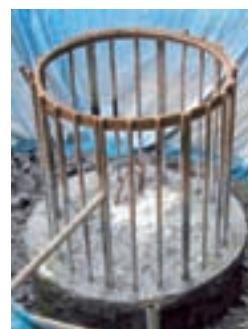
写真6 杭頭はつり後の鉄筋かごの状況
