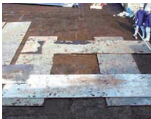
写真3 敷き鉄板枰の敷設
