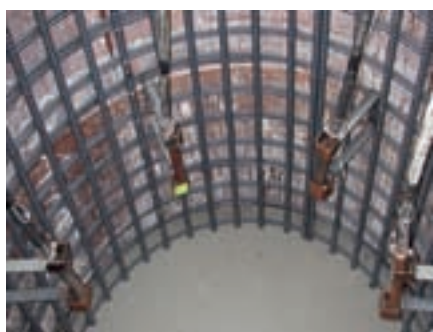
写真8 パイブレータの設置状況
