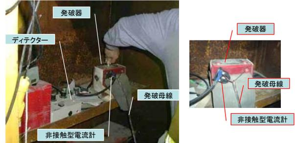
写真3 発破時の非接触型電流計とディテクター
