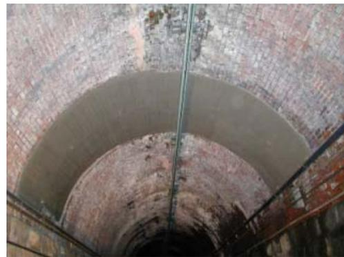
図 8 煉瓦トンネルへの適用事例
