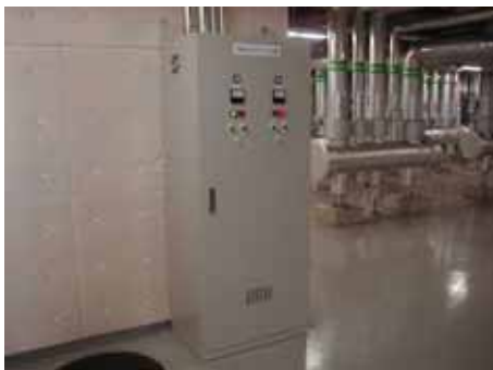
写真 1 新設インバーター盤
