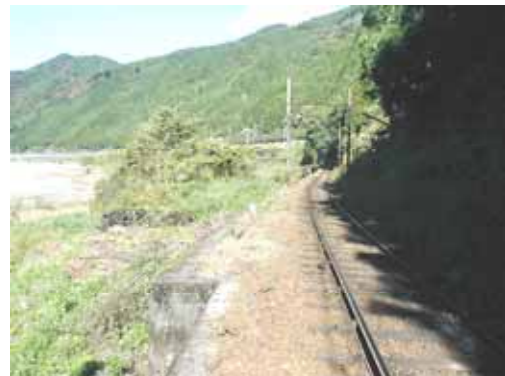
写真 4 Point A の状況
