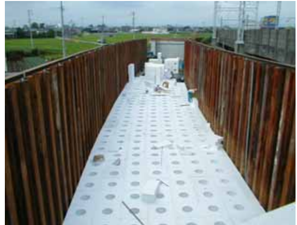
写真2 EPS ブロック 1 段目施工状況
