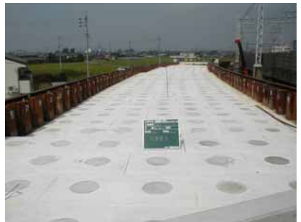
写真3 EPS ブロック 1 ~ 12 段目敷設完了状況
