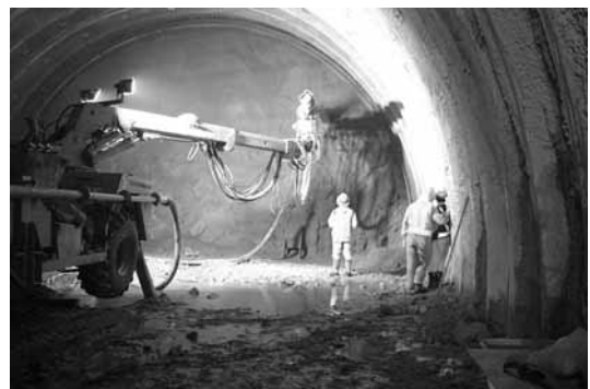
図 9 エアレス吹付けによる吹付状況
