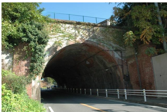
成宗電車第二トンネル
