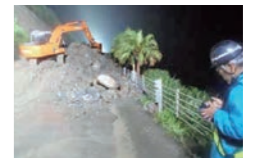
国道220号応急復旧の様子
