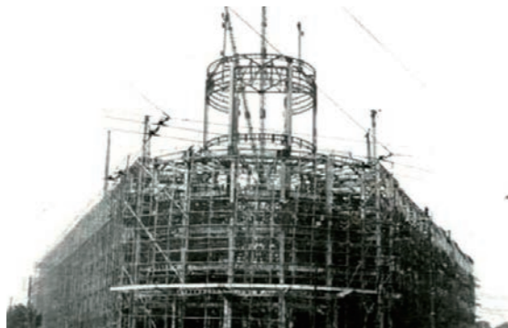
警視庁庁舎鉄骨工事
