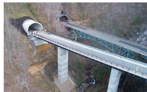
新三国トンネル(2021年)
