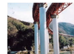
東名高速道路河内川橋の補強工事
