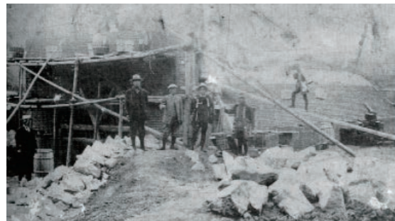
成宗電車軌道敷設工事
