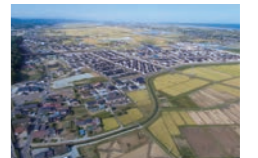
再整備を行なった宮城県巨理郡山元町(フジタ)
