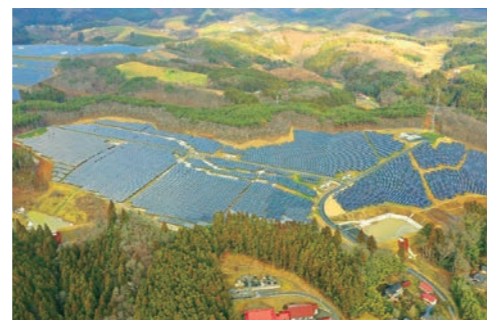
気仙沼太陽光発電所(2021年)
