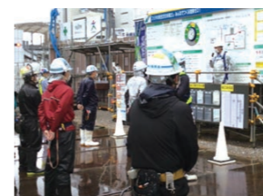
経営トップによる安全パトロール
