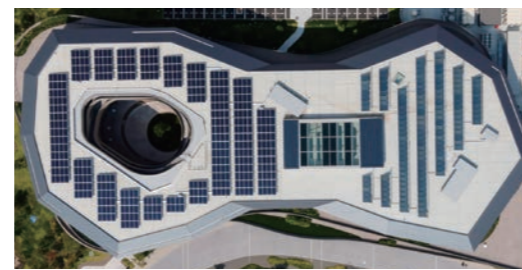
左：太陽光パネル、右：太陽熱集熱パネル
