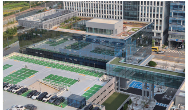
東京エレクトロンコリア株式会社 平澤 PTSC2（2025 年 10 月竣工）
