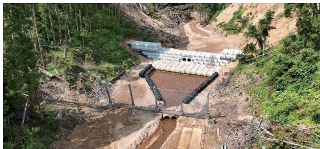
2026 年 3 月に竣工した 令和 6 年能登半島地震町野川（牛尾川）緊急復旧工事
