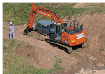
「ロボ QS」を用いた道路啓開訓練
