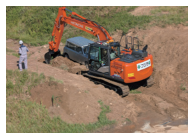
「ロボ QS」を用いた道路啓開訓練
