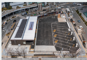
マルビル 大阪・関西万博バスターミナル 解体工事
