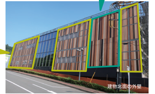
木材を打込んだプレキャストコンクリートカーテンウォール
