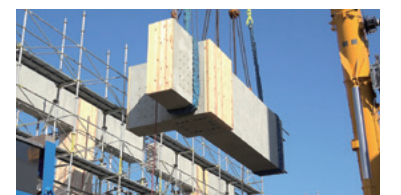
工場で作成して現場で組み立てるプレキャストを導入。地上躯体は耐震壁以外すべてプレキャスト化
