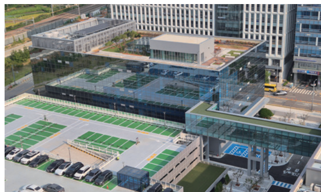
東京エレクトロンコリア株式会社 平澤 PTSC2（2025 年 10 月竣工）
