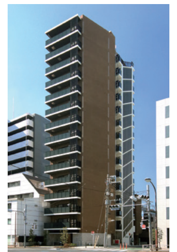
自社開発プロジェクト「リーラ品川戸越」 （東京都 2026 年 2 月竣工）
