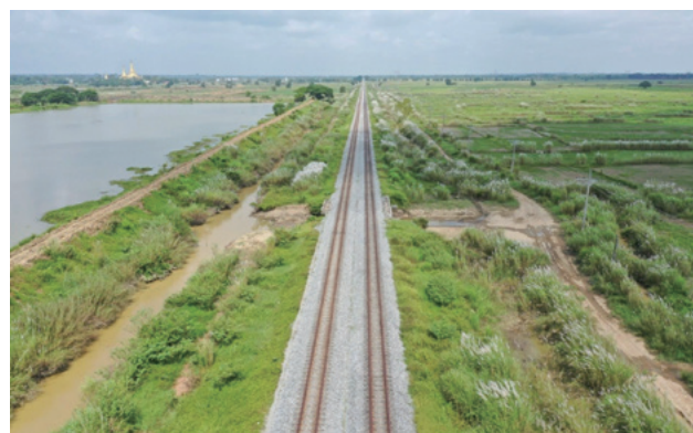
ヤンゴン・マンドレー鉄道 (ミャンマー連邦共和国ヤンゴン市・2024年11月竣工)
