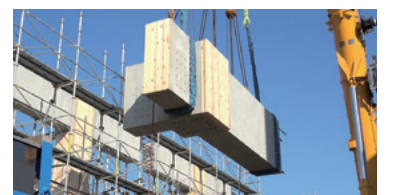
工場で製造して現場で組み立てるプレキャストを導入。地上躯体は耐震壁以外すべてプレキャスト化
