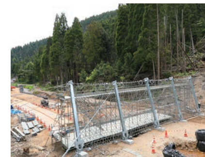
強靱ワイヤーネットを再度設置
