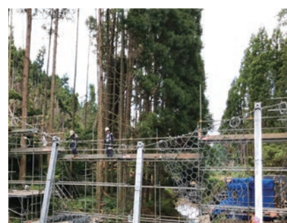
流木を捕捉するための強靱ワイヤーネット
