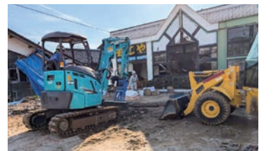
スーパーでの復旧作業
