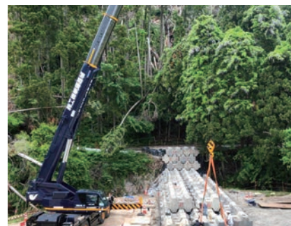
100トンラフタークレーンでコンクリートブロックの設置
