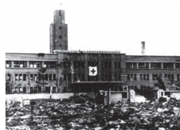
当社が復旧を行なった 広島赤十字病院
