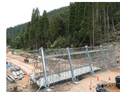
強靱ワイヤーネットを再度設置
