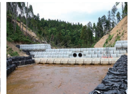
強靱ワイヤーネットの上流に新たなブロック堰堤を作成
