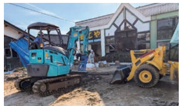
スーパーでの復旧作業
