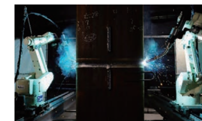
溶接用ロボットによる鋼管柱の溶接状況
