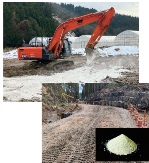
FTマッドキラーにより改良した仮設道路
