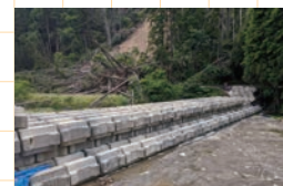
ブロック堰堤
