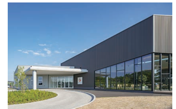
ZEB Ready認証建物 (株)プレステージ・インターナショナル 岩手BPOフォートレス(岩手県一関市)
