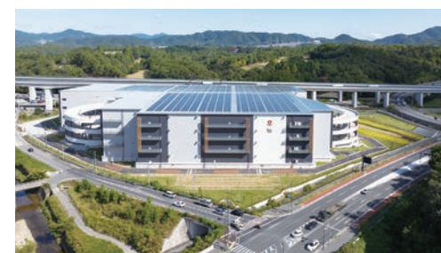
DPL兵庫川西(2023年竣工)
