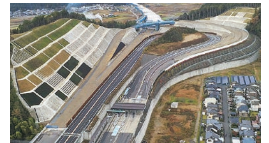
東海環状自動車道 山県インターチェンジ(2023年竣工)
