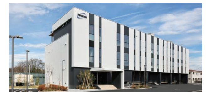
ZEB Ready認証建物 神奈川電設株式会社本社(神奈川県茅ヶ崎市) Photo by Masato Kawano (Nacása & partners Inc)
