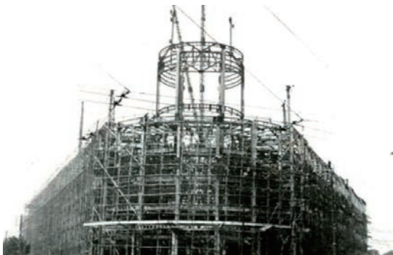
警視庁庁舎鉄骨工事
