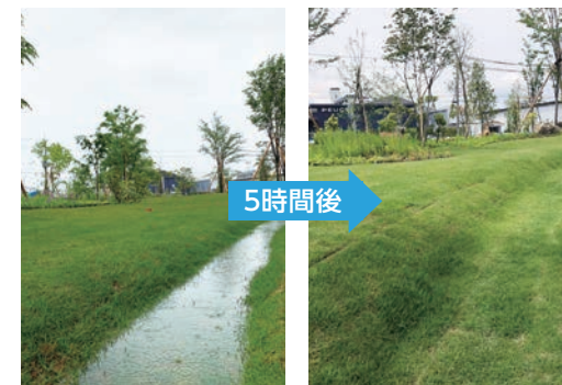
レインガーデン 左：降雨時、右：降雨後5時間経過後
