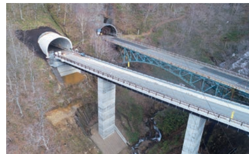
新三国トンネル(2021年)
