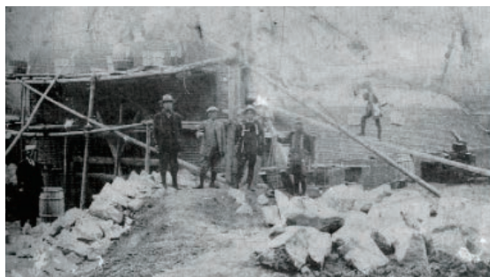
成宗電車軌道敷設工事
