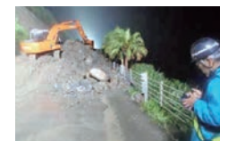
国道220号応急復旧の様子
