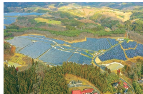
気仙沼太陽光発電所(2021年)
