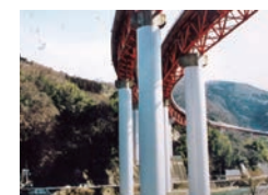
東名高速道路酒匂川橋の補強工事
