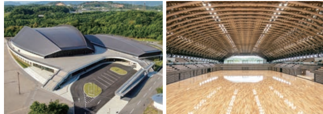
大分県産のスギを使用したダイナミックな大屋根の架構が印象的
