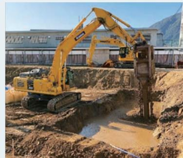
エコプラス活動事例：地盤改良の設計変更（スタビミキサー工法）により、残土や廃棄物（コンガラ）排出量を大幅削減
