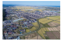
再整備を行った宮城県巨理郡山元町(フジタ)
