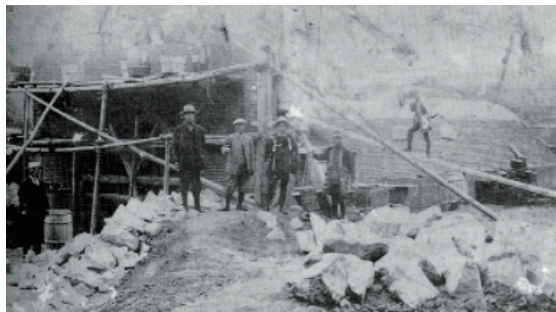
成宗電車軌道敷設工事
