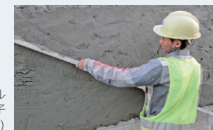
レンガ壁にモルタルを施工している様子(ミャンマー)
