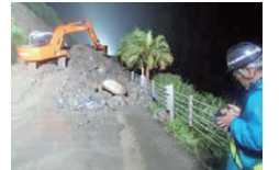
国道220号応急復旧の様子
