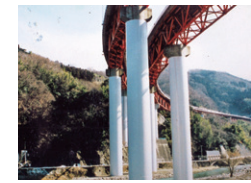
東名高速道路酒匂川橋の補強工事
