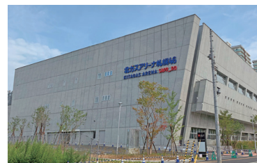
北ガスアリーナ札幌46外観
