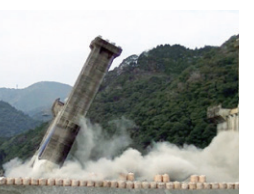
発破解体する荒瀬ダム
