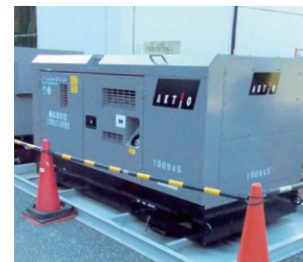
ゼネレーター漏油対策
