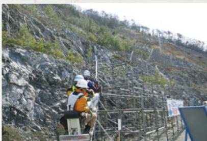
調査員や資材の運搬用に設置したモノレール
