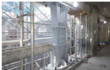
揺れを抑える鋼製パネルダンパー
