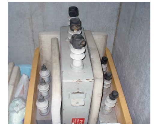
PCBの保管状況(技術センター)
