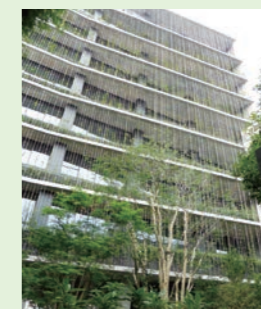
壁面に配置されたワイヤー、鎖樋は3,700本にもものぼり、1,800㎡の壁面緑化は国内最大級の規模。
