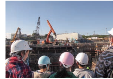
地下のゴミピットの掘削作業を見学
