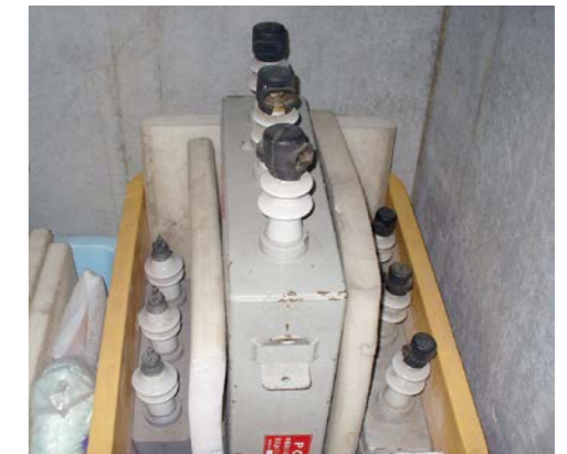
PCBの保管状況(技術センター)
