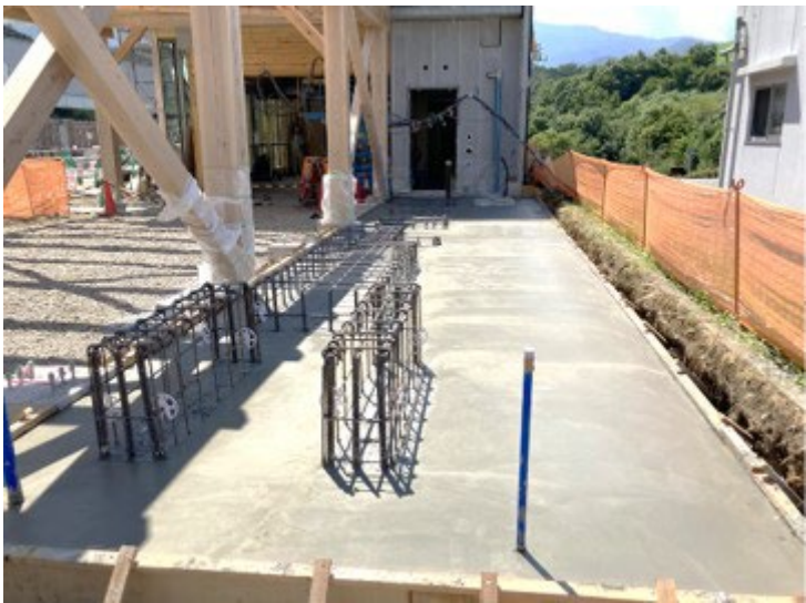
【フジタ技術センター付属棟「続」での施工例】
