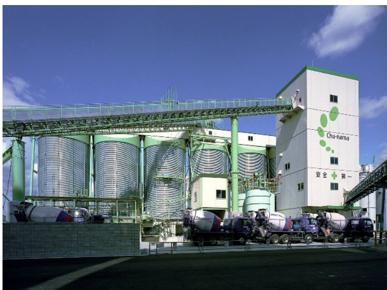
中国生コンクリート
