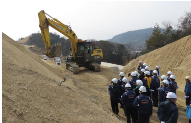
重機搭載レーザー計測デモ
