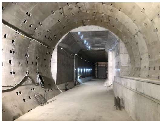
終端覆工後の千里中央駅北端部 (南行シールドトンネル)
