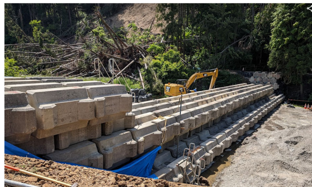
【対策工事の一例（ブロック堰堤）】
