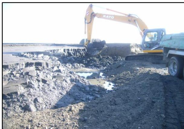
写真④ 土質不良箇所（例：港湾工事）
