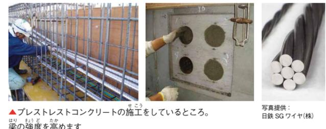
PC構造では、コンクリートの中に鉄筋の5～6倍も強い「PC鋼より線」と呼ばれるワイヤを何本も通します。「PC鋼より線」の両側を引っ張ることによって、コンクリートに圧力(ストレス)を加え、丈夫な梁が出来上がります。これなら、安心してどんなスポーツでもできますね。
