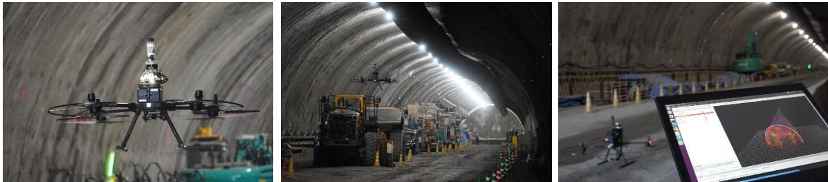
図1 トンネル坑内のドローン自律飛行
