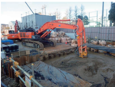
A : 機械攪拌法 -Machine Mixing Method-
