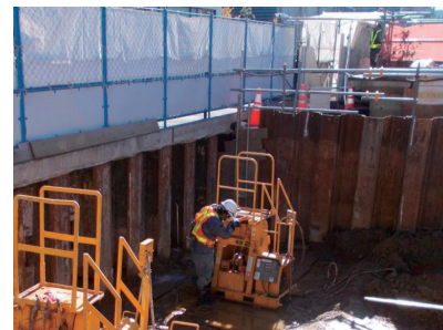
B : 加圧注入法 -Pressure Injection Method-
