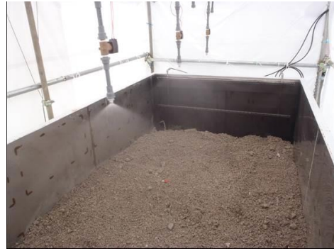
散水処理状況
