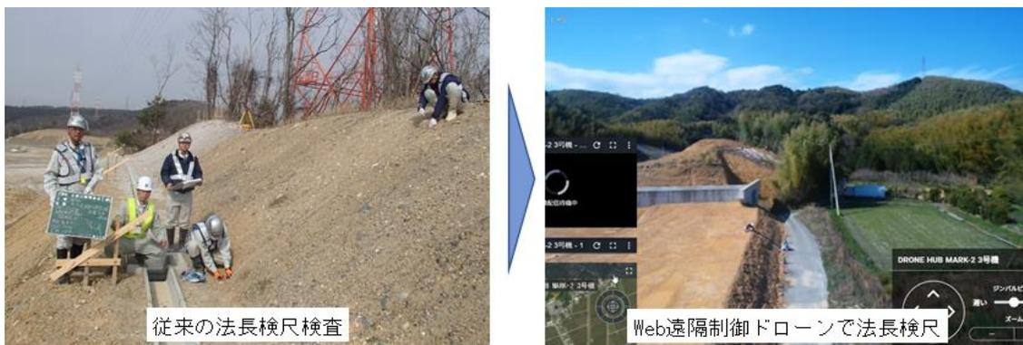
写真1 Web 遠隔制御ドローン運用
